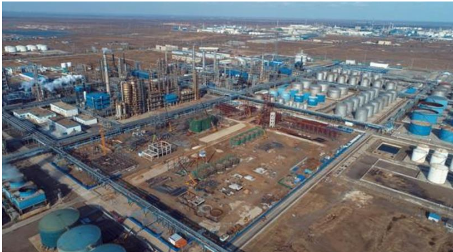
図 石油系NCプロジェクト建設現場
